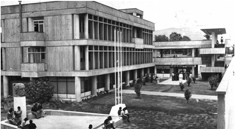
Fig. 3 Campus Saucache de la Universidad del Norte. Arquitectos Eduardo Garretón y Hernán Calvo. 1966-67. Foto c.1970. Arica. Archivo Histórico Vicente Dagnino, Universidad de Tarapacá.
