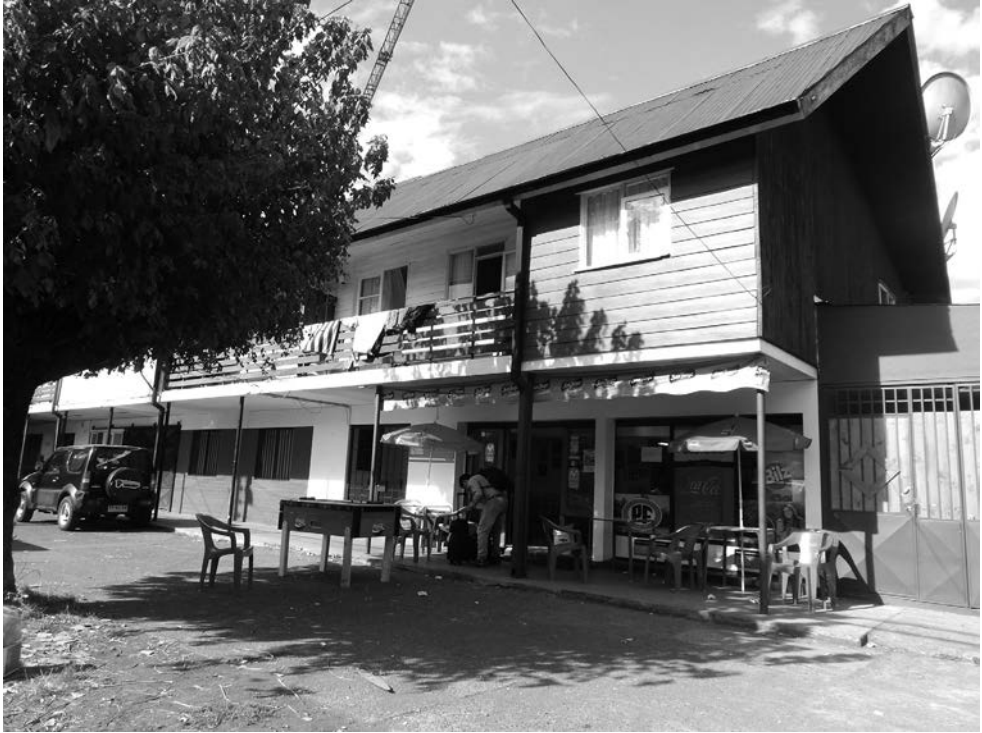
Fig 3. Tipología de vivienda colectiva adaptada en su primera planta para usos comerciales. Fuente: Autores.
