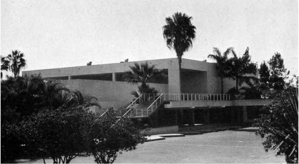
Fig. 1 Casino de Arica. Arquitectos Bresciani, Valdés, Castillo, Huidobro. 1960-61. Foto c.1970. Arica. Colección Balby Morán.
