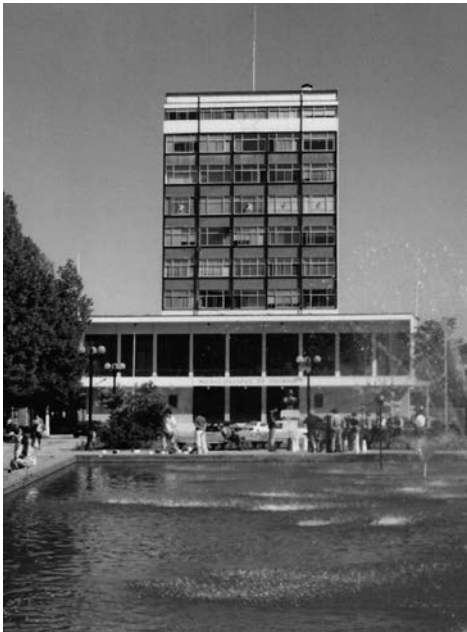
Fig 1. Fachada norte Edificio. Consistorial circa años 1970, 2000, 2015.
